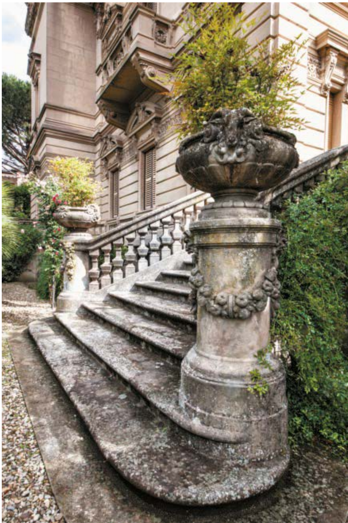
Vista della scala sul retro
