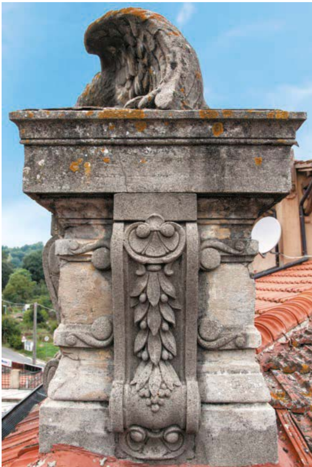
Particolare della Colombaia della Rimessa
