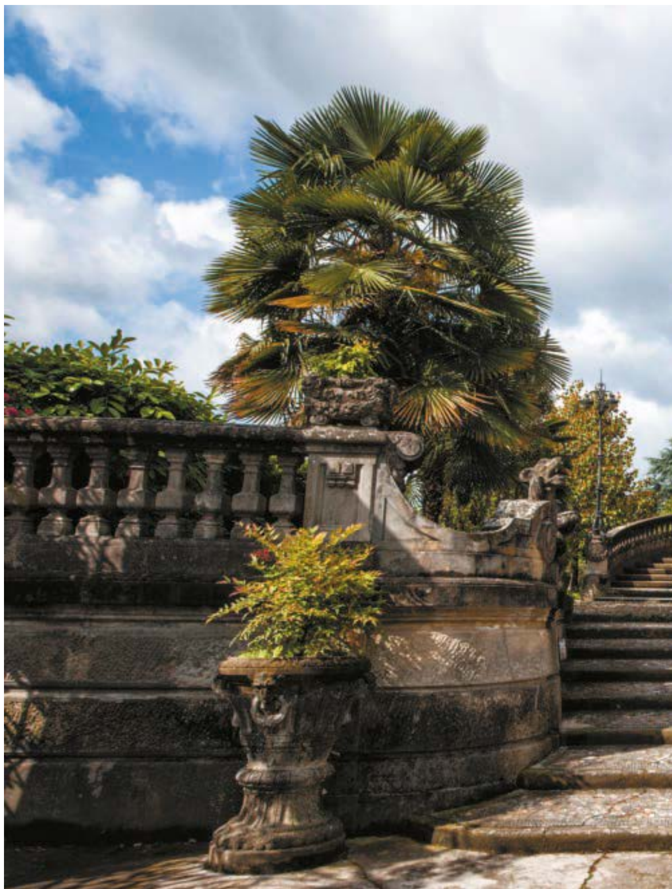
Ingresso principale di Villa Masini
